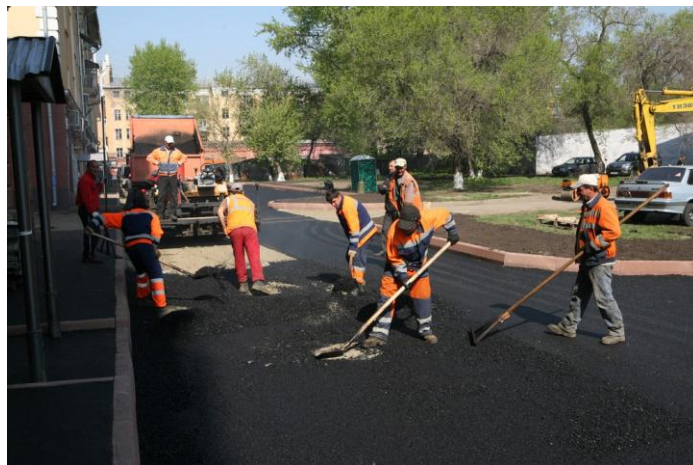
Ремонт дворовых проездов (минимальный перечень) (средняя стоимость: 738 руб./кв.м покрытия)
